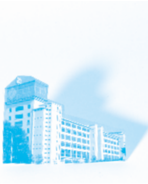
#1, #3, #10, #24, #65 Klokgebouw Eindhoven Strijp 51°44'88.25"N 5°45'78.13"E
